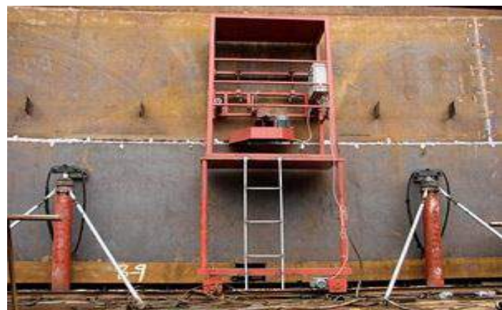
Сварка горизонтального шва стенки резервуара
