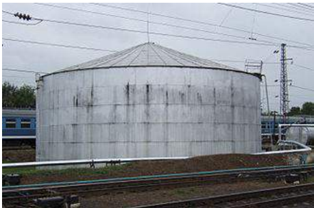
Клепанный резервуар Шухова на ж/д станции в г.Владимир
