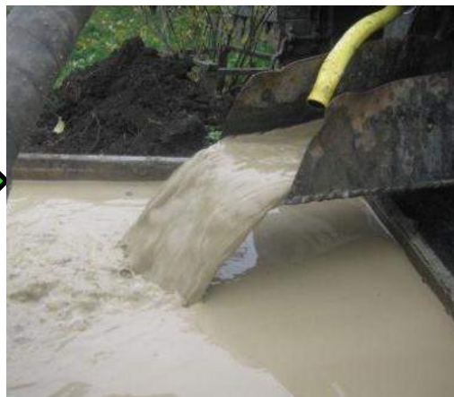
Промывка ствола (буровой раствор)
